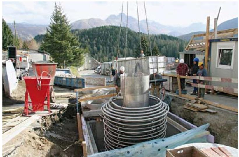
Particolare sistema FEKA per il recupero del calore lato circuito primario dalle acque reflue di scarico con temperature comprese tra i 25 ° C e i 35 ° C. (Vengono realizzate delle vasche di circa 35 m<sup>3</sup> per ogni Vitocal 350-HT)
